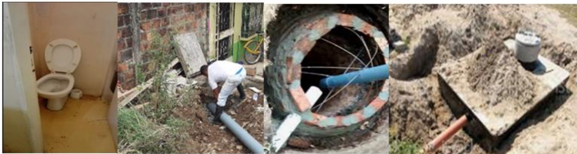
Excusado conectado a pozo ciego
