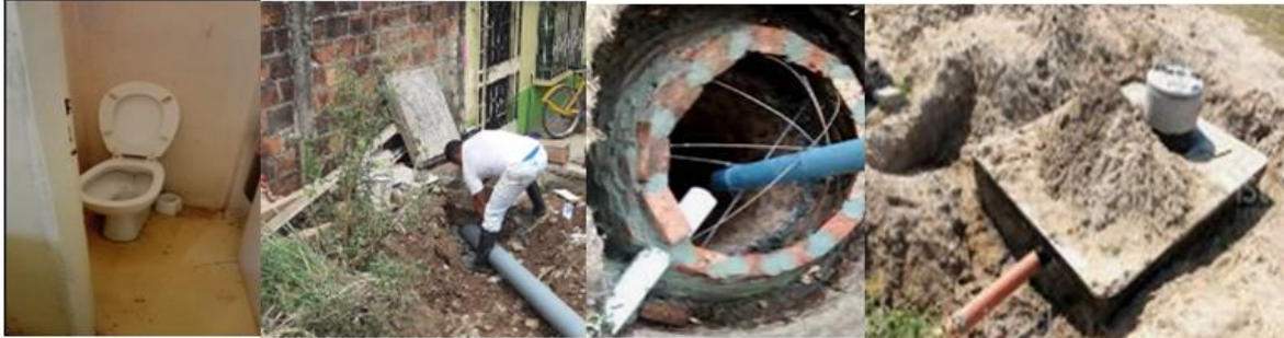
Excusado conectado a pozo ciego
