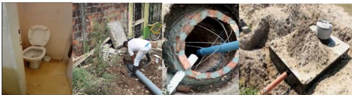
Excusado conectado a pozo ciego
