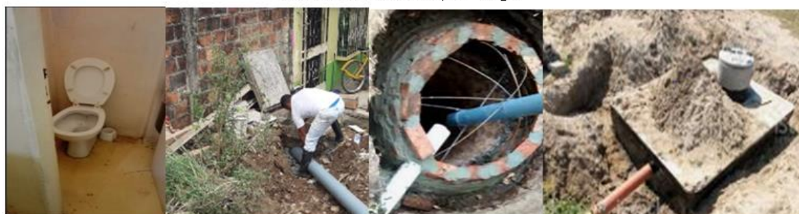
Excusado conectado a pozo ciego
