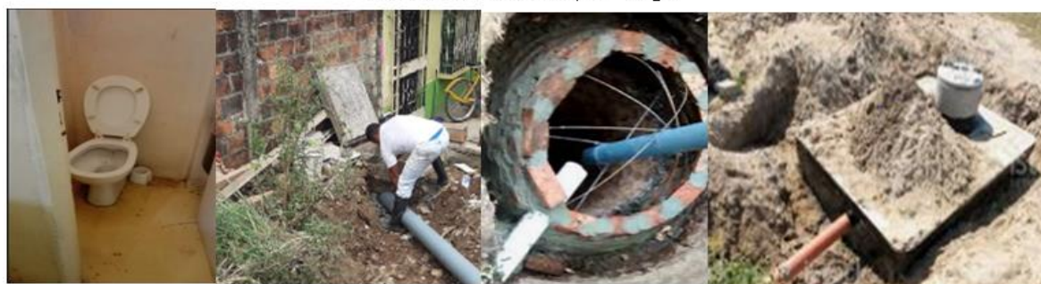
Excusado conectado a pozo ciego
