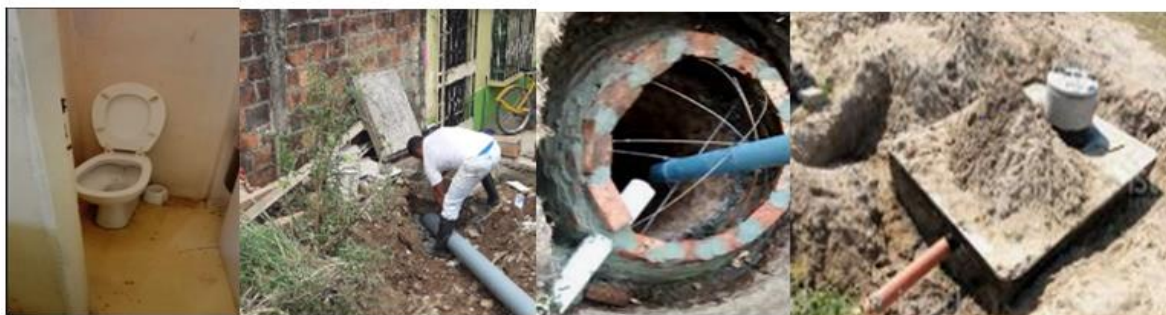
Excusado conectado a pozo ciego
